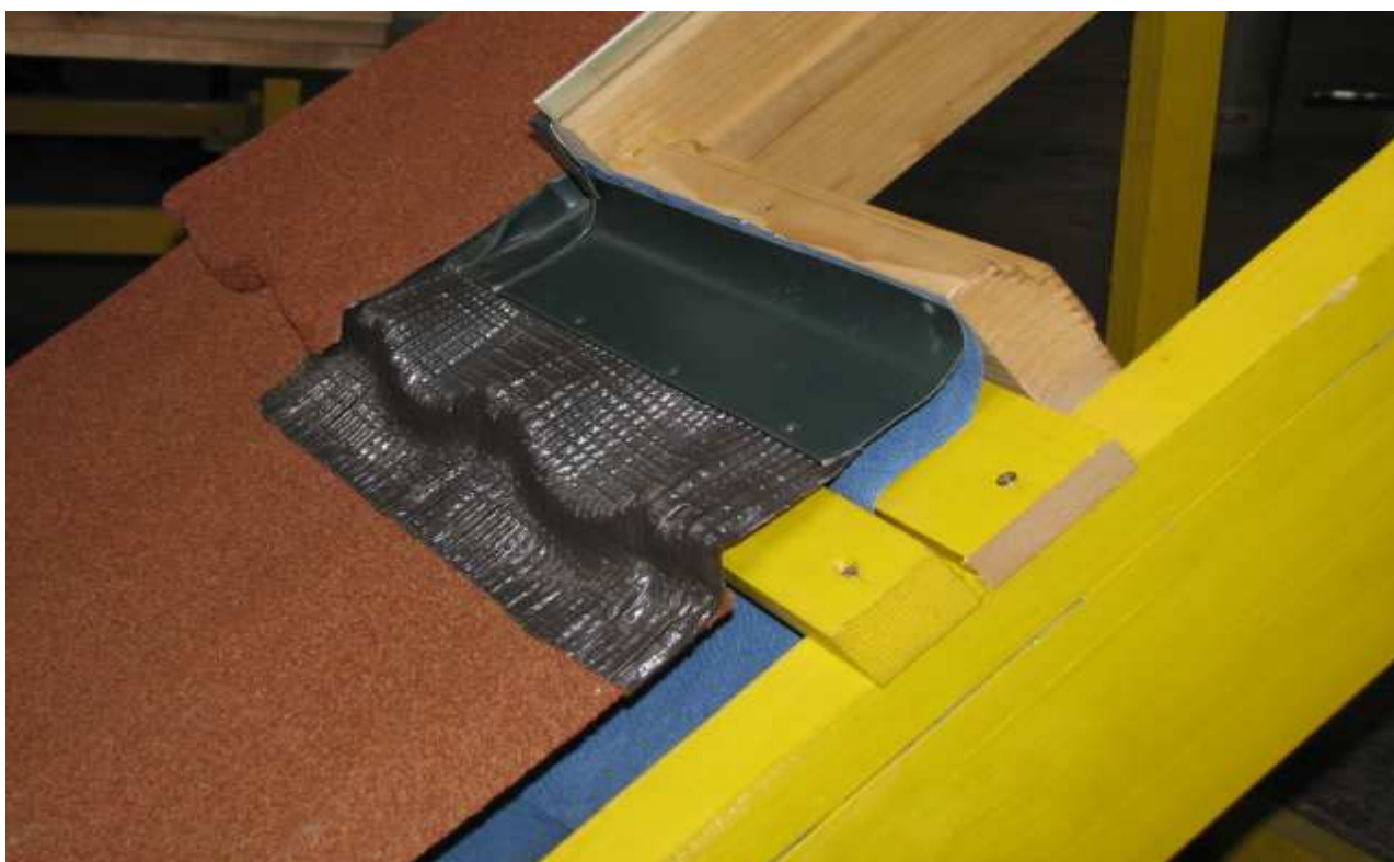
Obr.23 Úprava dolného ostenia strešného okna
