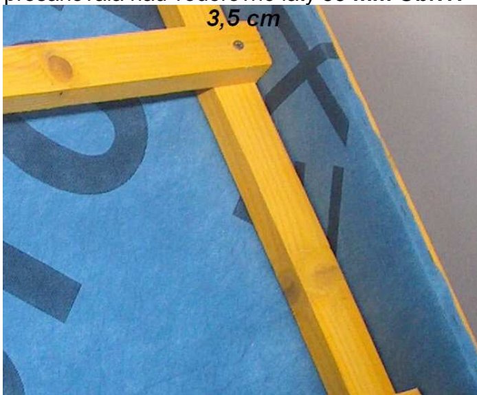
Obr.17 Presah štítovej dosky
