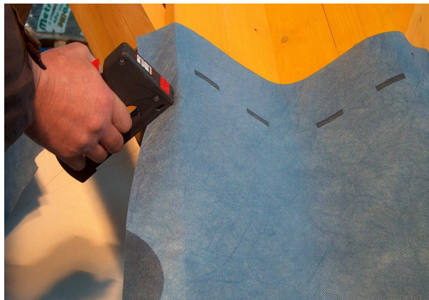
Obr.9 Spinkovanie fólie na hranu úžľabia
