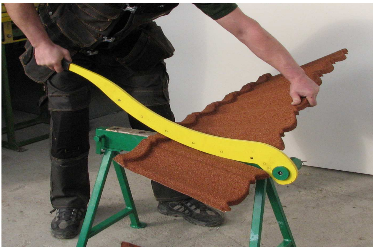
Obr.24 Delenie strešnej krytiny
