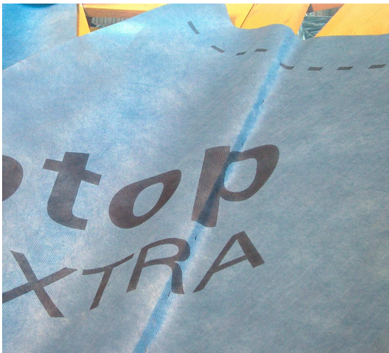
Obr.10 Priečne preloženie fólie sprava cez úžľabie
