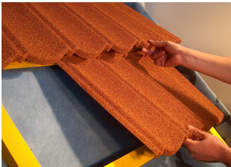
Obr.30 Podkladanie krytiny pod horný rad
