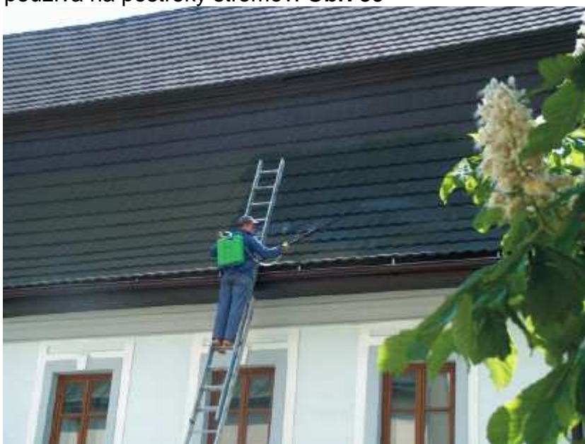
Obr.39 Nanášanie prípravku METROGARD
