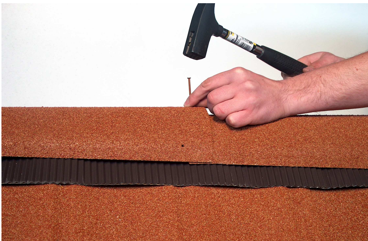
Obr.35 Uchytenie hrebenáčov klincom v najvyššom bode
