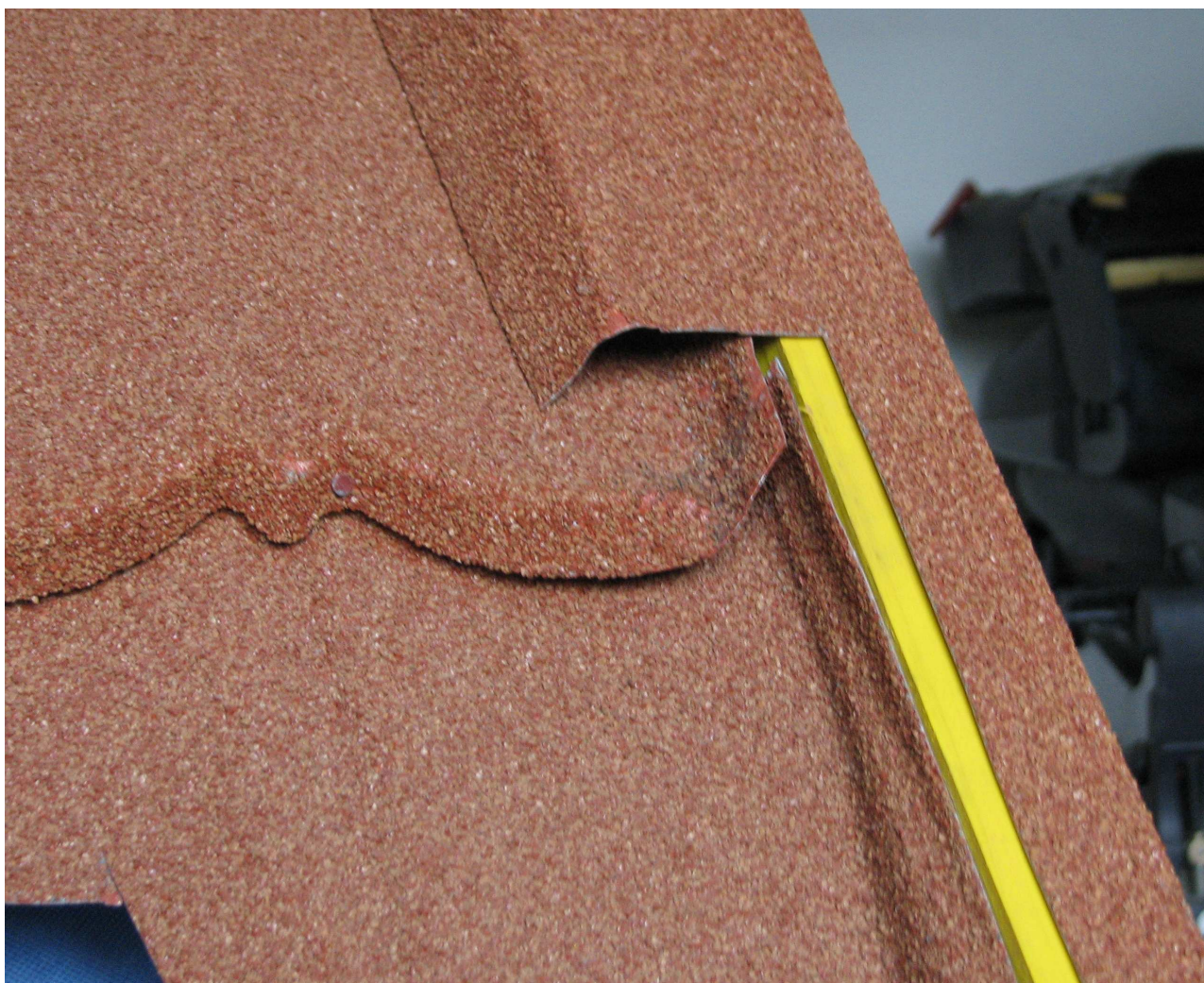
Obr.38 Reálny detail okrajovej lišty a zapracovania strešnej krytiny pri štítovej doske
