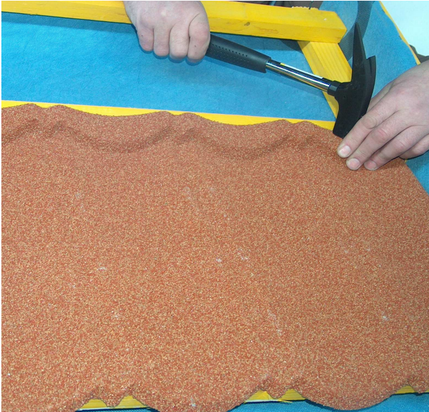
Obr.26 Uchytenie druhej rady krytiny
