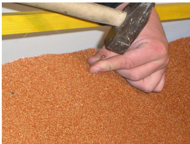
Obr.29 Prichytenie prvej rady klincom
