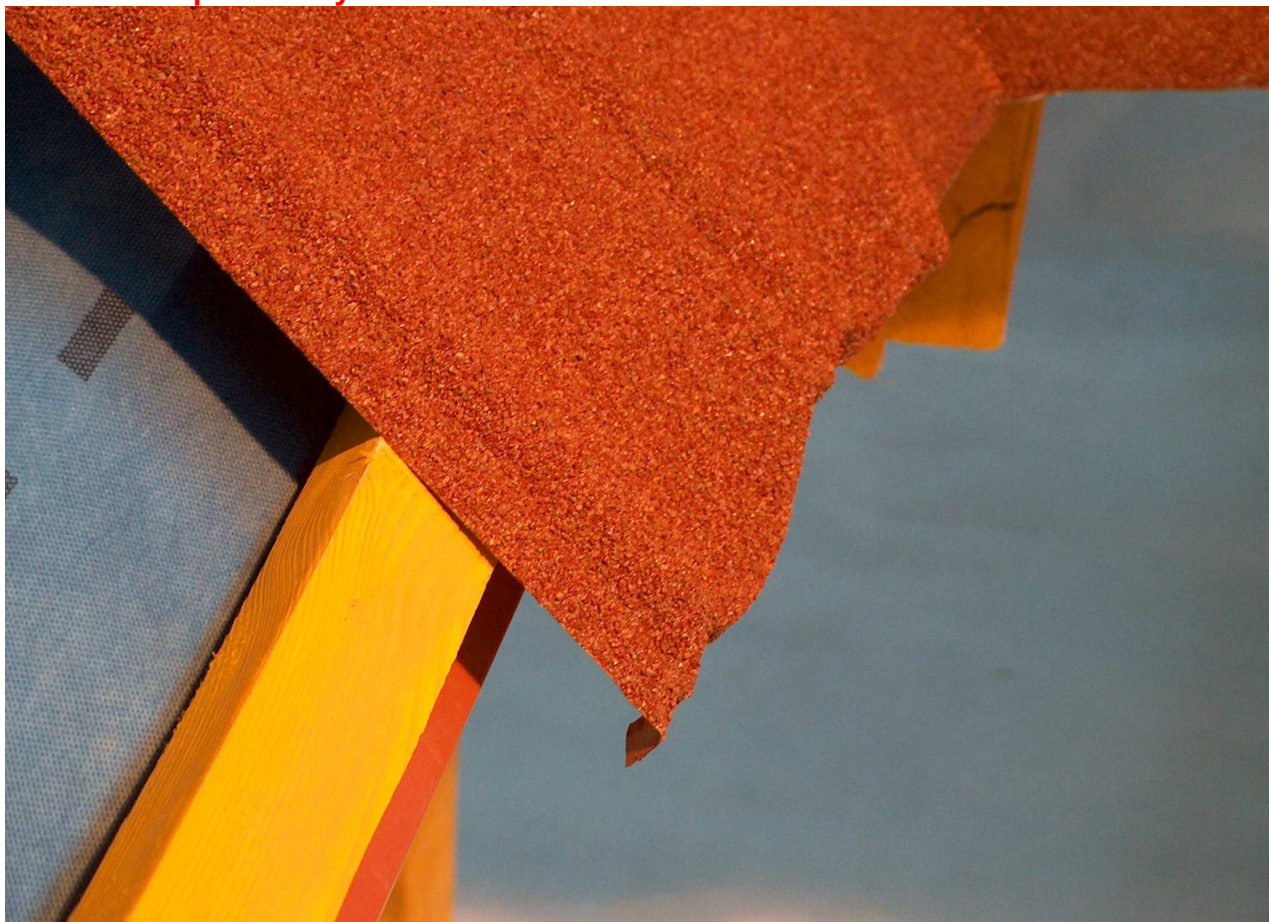
Obr.18 Presah prvej rady krytiny pri odkvapovej hrane
