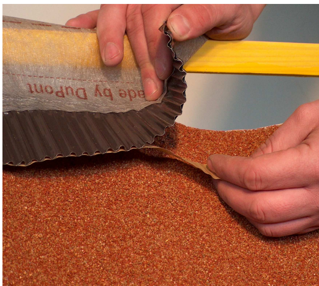
Obr.33 Lepenie vetracieho pásu ku krytine
