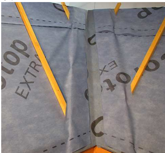
Obr.12 Začiatok kontralatovania pri úžľabí
