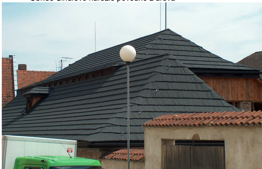
Obr.37 Šindľové nárožie z Metrošindla
