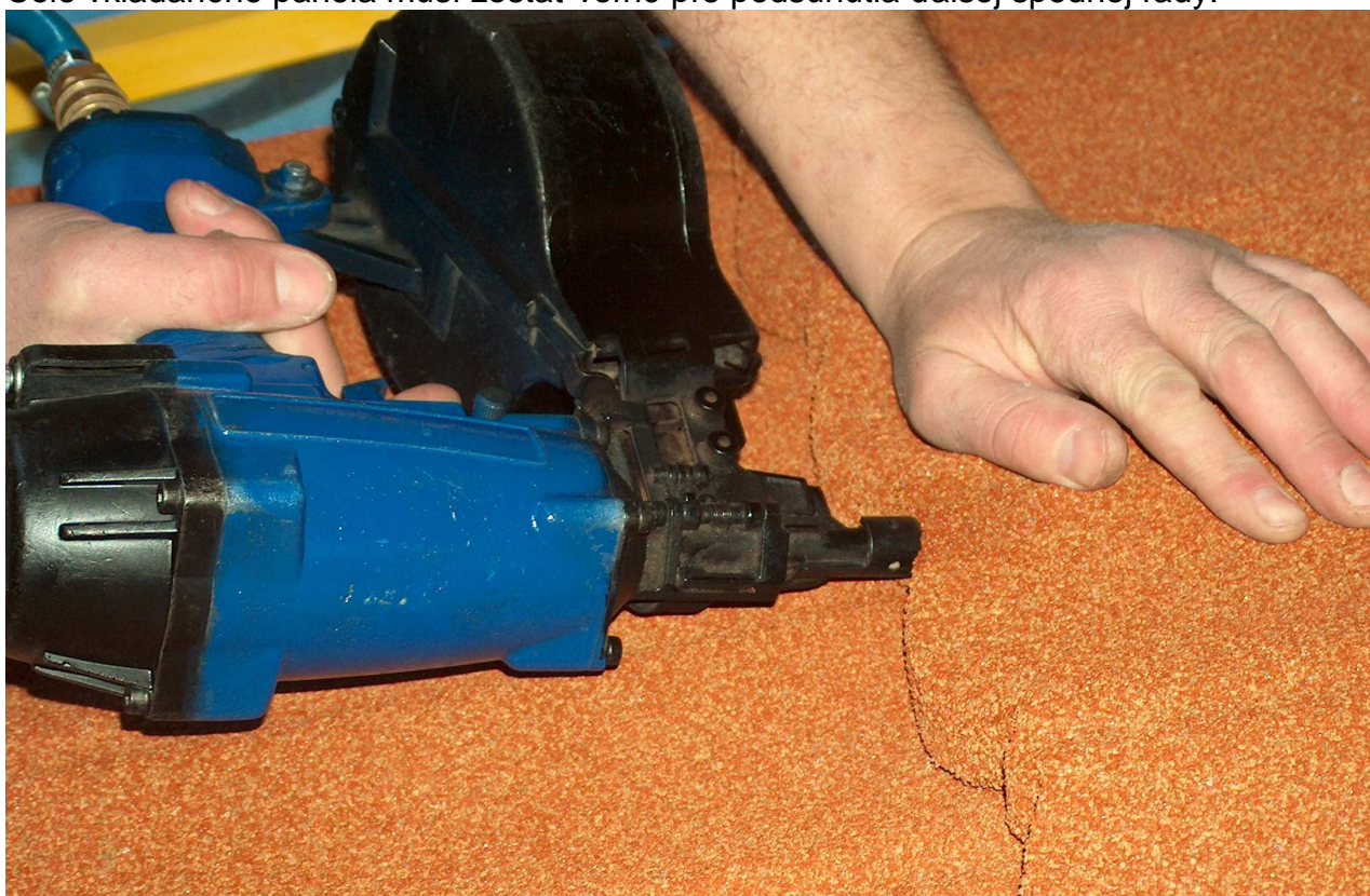
Obr.31 Prichytenie krytiny pneumatickou kľincovačkou.
