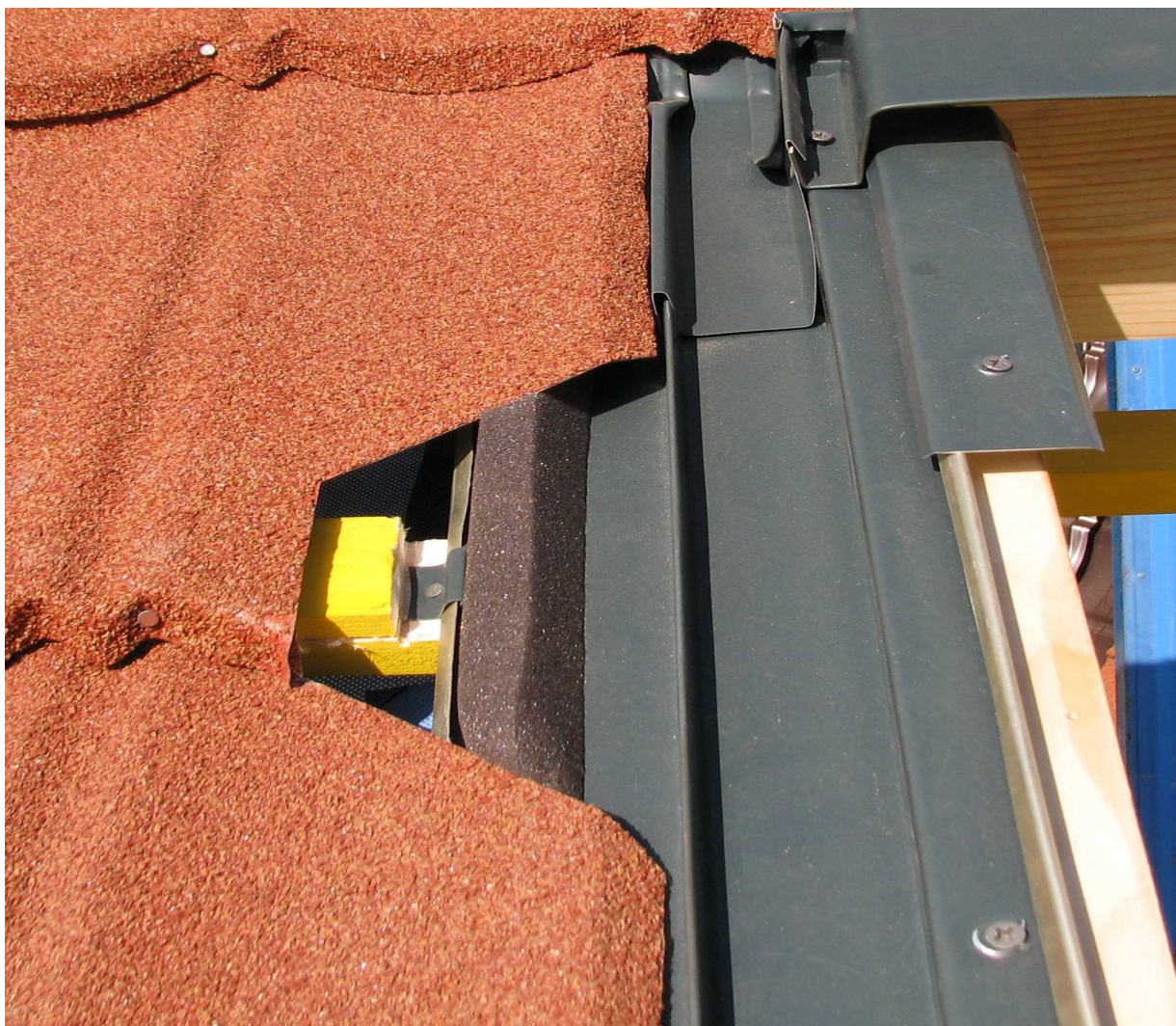
Obr.21 Bočné lemovanie a osadenie krytiny pri strešnom okne
