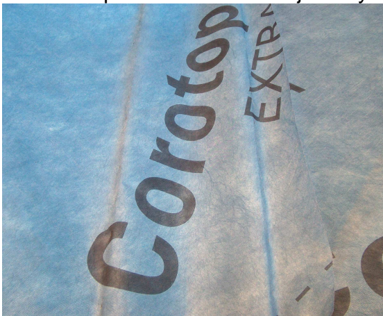
Obr.11 Priečne preloženie fólie zľava cez úžľabie
